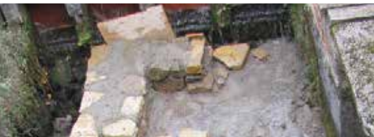
Sanacija tlaka pod mlinskim kolesom ter obnova fasade.
